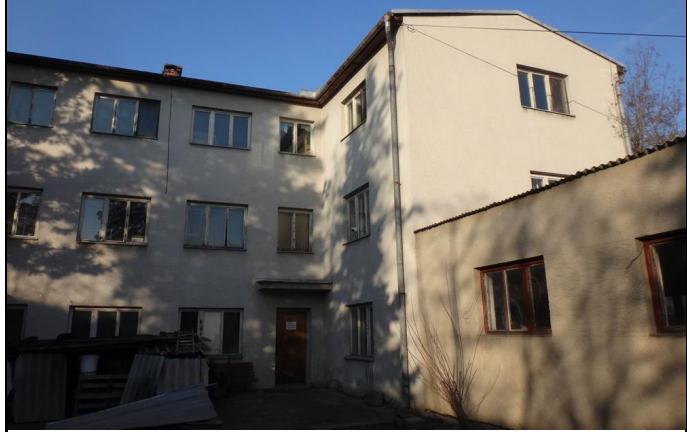
Objekt č.p. 308 - obč. vyb, na pozemku p.č. 768/12 (pozemek není předmětem ocenění)
