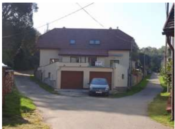
Přístup k pozemku vlevo i vpravo po asfalt. komunikacích (pozemek je za domem čp. 14 a rozestavěným dvoudomem)
