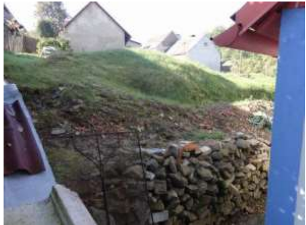
Opěrná zídka na severní straně
