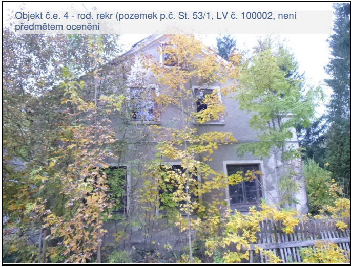
Objekt č.e. 4 - rod. rekr (pozemek p.č. St. 53/1, LV č. 100002, není předmětem ocenění)
